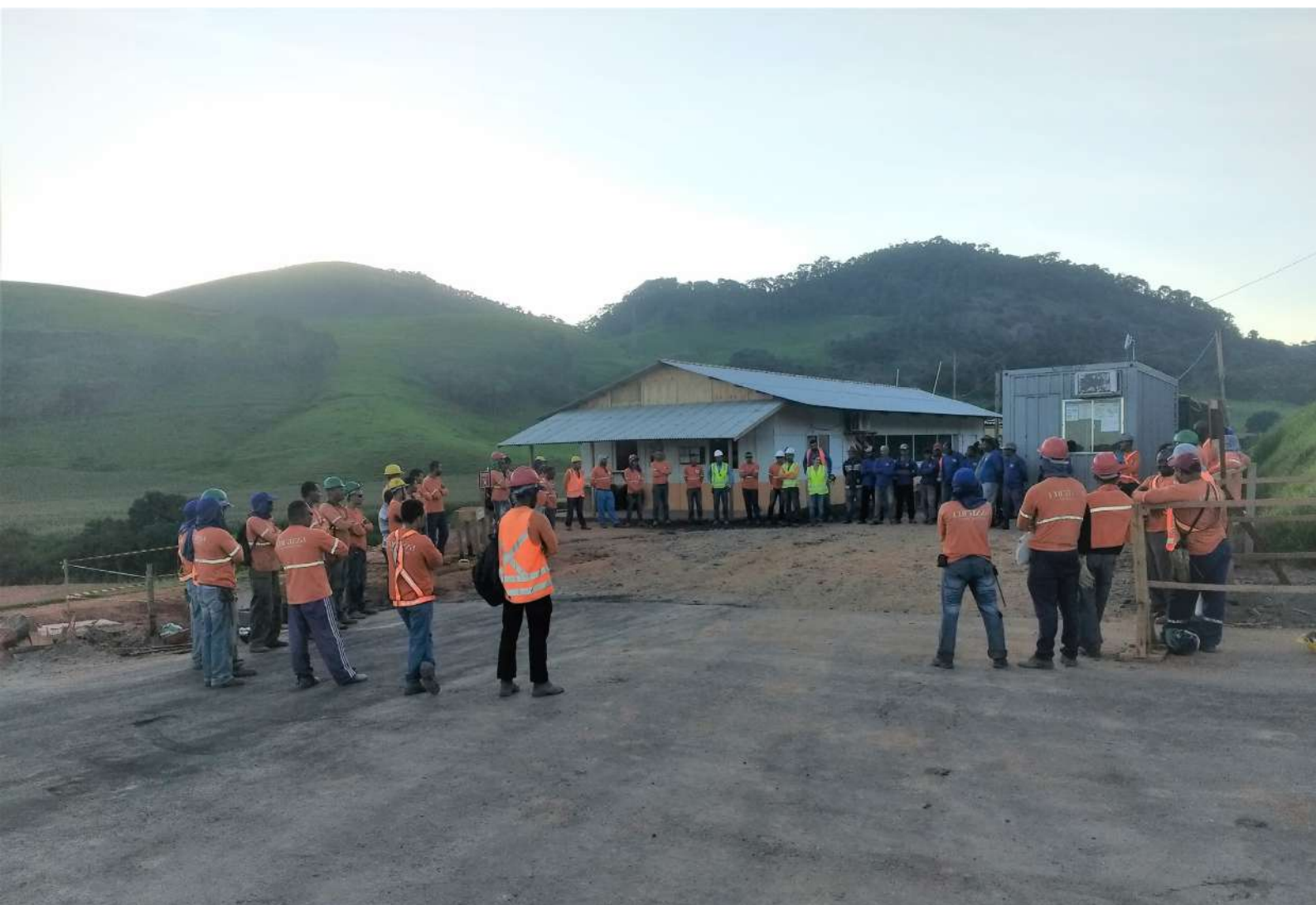
Exemplo de canteiro de obras. Fonte: LDC, 2020.
