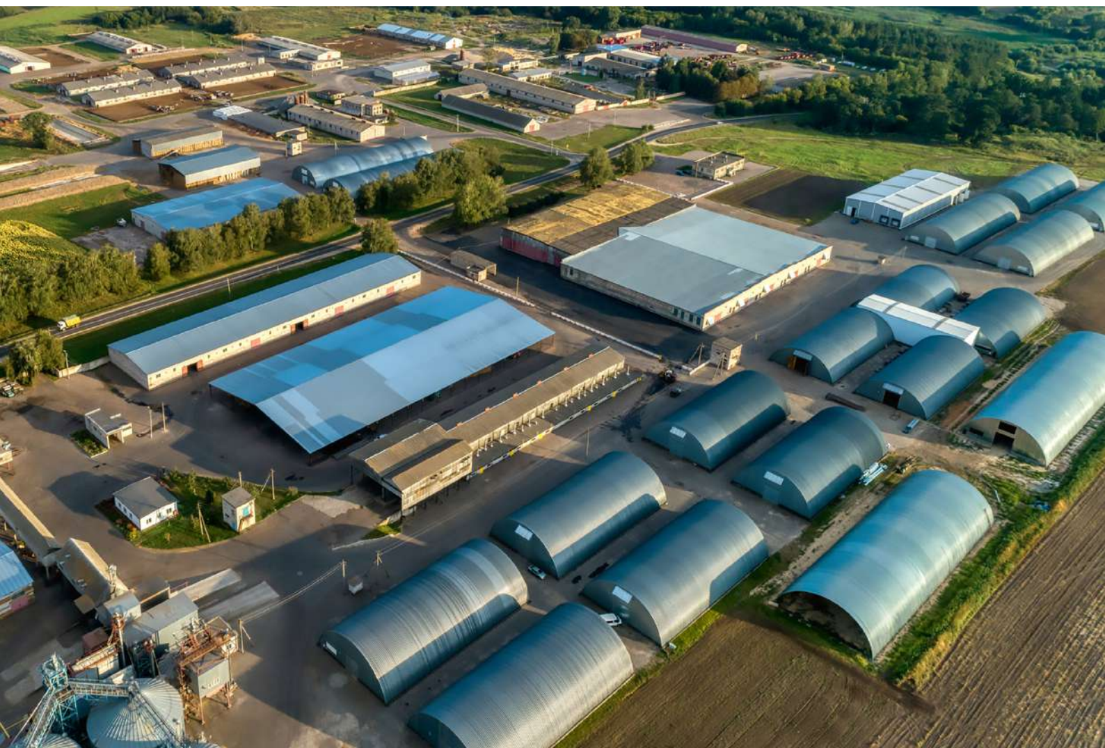
Exemplo de armazéns com cobertura metálica. Fonte: iStock, 2019.
