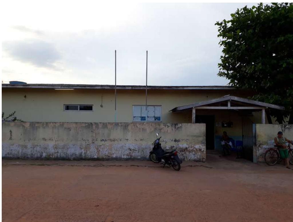
Posto de Saúde na sede de Ponta de Pedras.
